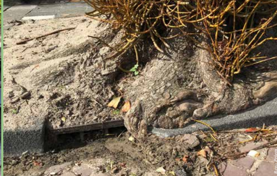
Boom staat te dicht bij een trottoirkolk
