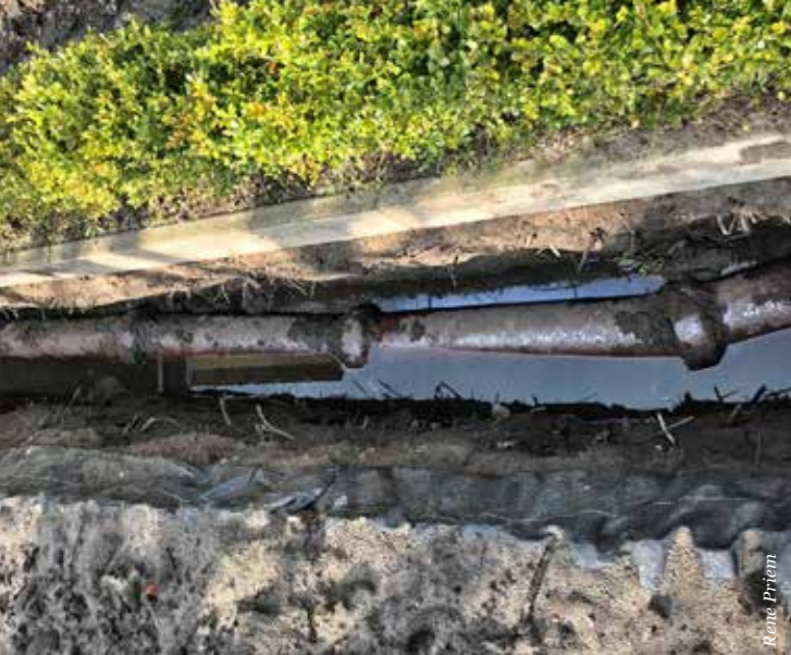
Gresbuizen bij een huisaansluiting zijn kwetsbaar voor wortelgroei
