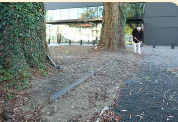
Tijdelijke rechtbank Amsterdam - in strijd met de afspraken is het maaiveld verlaagd voor het aanbrengen van basaltspilt
