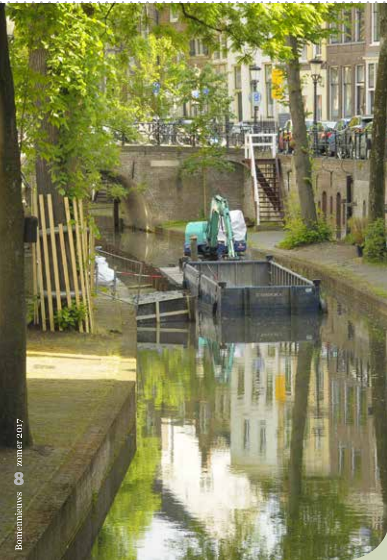
Herstel walmuren Nieuwegracht
