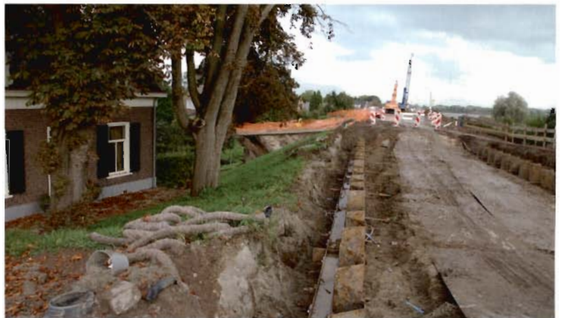
De dijk is versterkt met damwand. Bebouwing en bomen kunnen op deze wijze behouden blijven.
